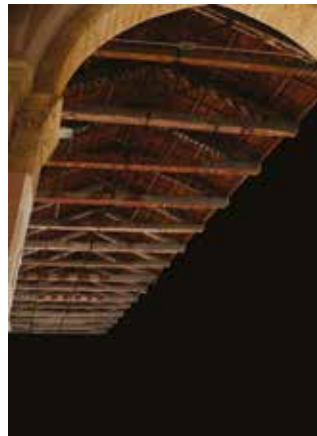
Chiesa di San Paolo: soffitto a capriate (sec. XIV)
