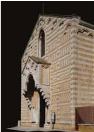
Santa Maria del Casale (XIV sec.): facciata con protiro
